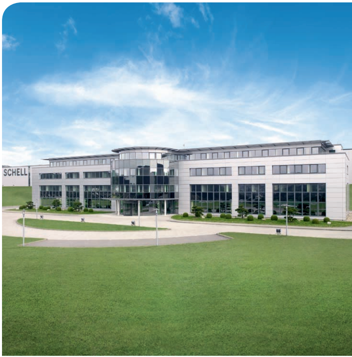
Zakład 1 – Hala produkcyjna z budynkiem administracyjnym i centrum szkoleniowym
