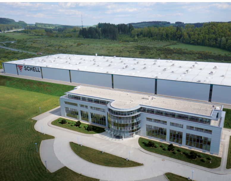
Werk 1 Produktion mit Verwaltungsgebäude und Schulungszentrum
