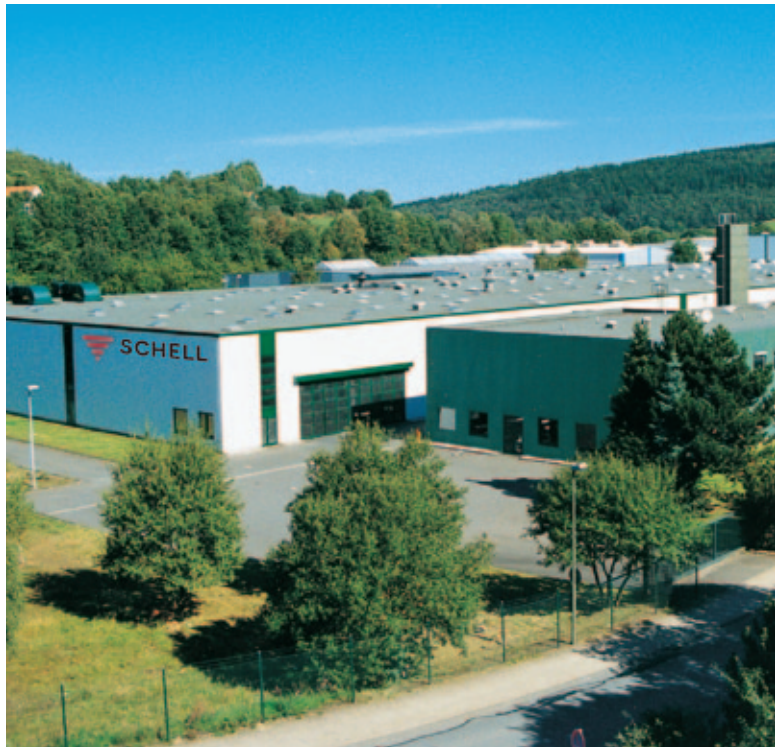
Závod 2 - výrobní hala s logistickým centrem Závod 2 - výrobní hala s logistickým centrem
