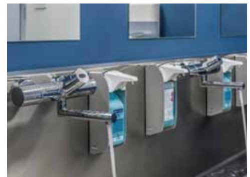
VITUS VW-E-T wastafelkraan met contactloze IR-activering
