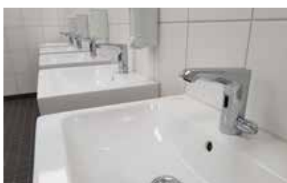
XERIS ET wastafelkraan met geïntegreerde thermostaat
