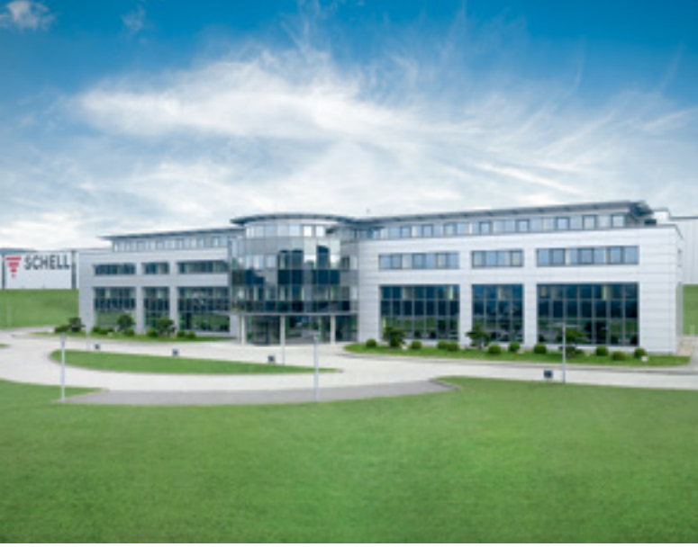
Fabrika 1 İdari bina ve eğitim merkezi bulunan üretim tesisi
