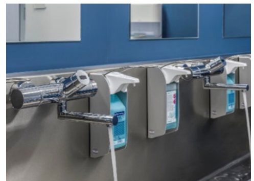
VITUS VW-E-T Waschtisch-Armatur mit berührungsloser IR-Auslösung
