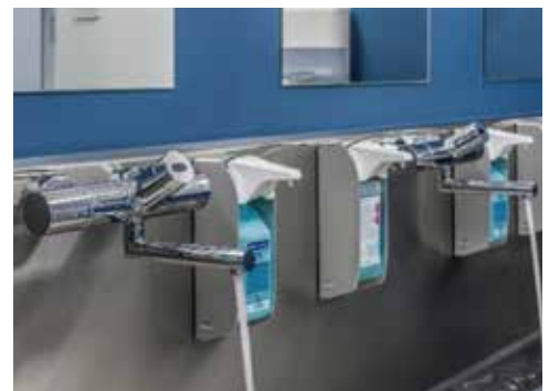
VITUS VW-E-T wastafelkraan met contactloze IR-activering
